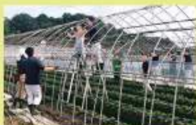
パイプハウスの撤去に取り組み中JA職員(鹿沼市)
